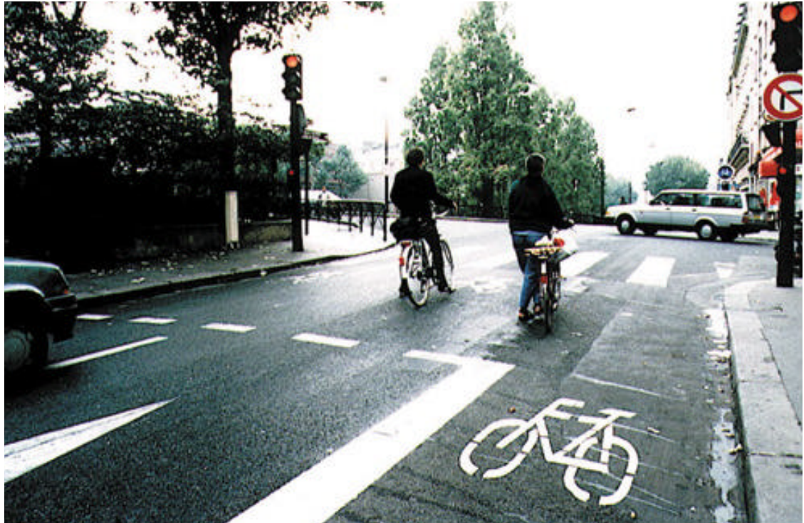
Mairie de Paris / Direction de la Voirie et des Déplacements - Exemple de sas vélo qui pourrait être utilisé par les rollers, sous réserve, bien entendu, qu'ils soient autorisés à rouler sur la chaussée.
